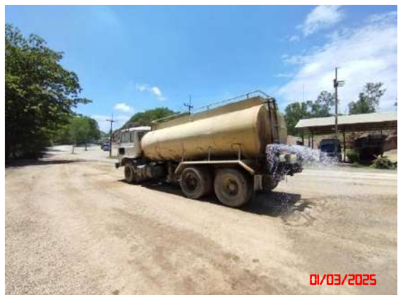
รูปที่ 4 การฉีดพรมน้ำเพื่อลดผลกระทบด้านการฟุ้งกระจายของฝุ่นละออง
