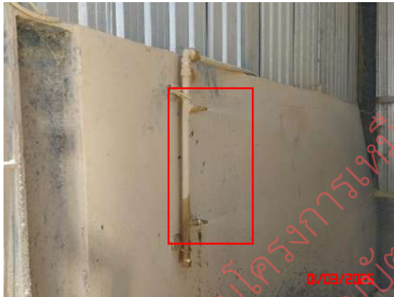
รูปที่ 7 ระบบเสปร์รน้ำภายในโรงโม่หิน
